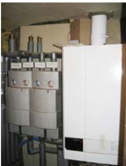
Abb. 39 Moderne, an der Wand hängende Gasbrennwerttherme
