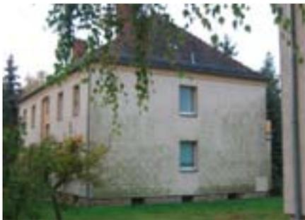
Abb. 12 Fassade nach Sanierung mit Wärmedämmverbundsystem, Algenbildung
