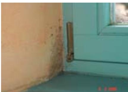
Abb. 14 Detail, Schimmel an einer Fensterlaibung nach Fensteraustausch
