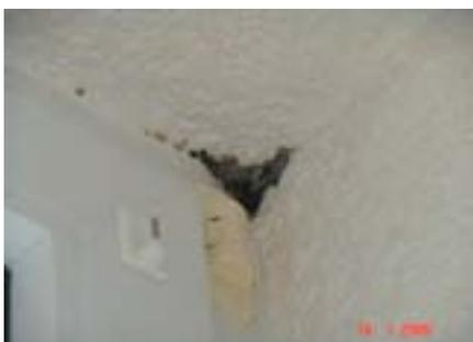
Abb. 13 Detail, Schimmel in einer Außenwanddecke nach Sanierung
