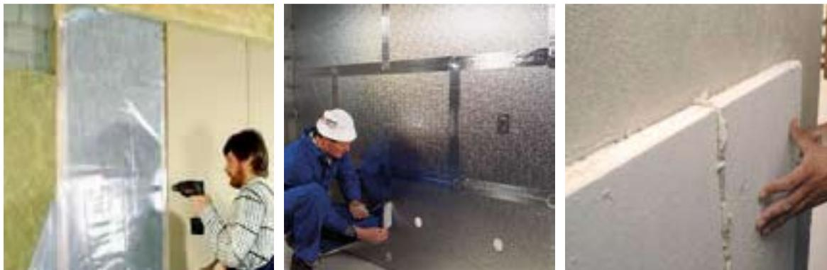
Abbildung 3.1.3 Innendämmsystem mit Dampfbremse (links), diffusionsdichter Ebene (mitte), kapillaraktiven Materialien (rechts), Bildquelle: [Haselsteiner 2006]
