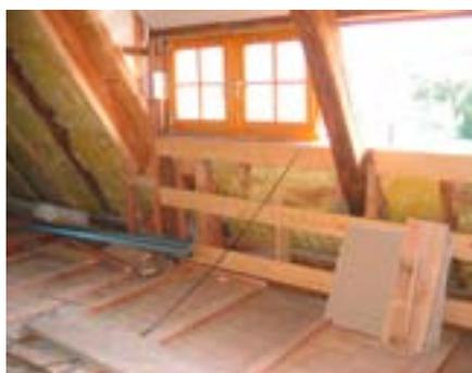
Abb. 8 Ausbau Dachgeschoss, Zwischensparrendämmung aus Glaswolle
