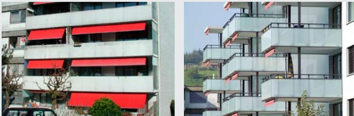
Abbildung 3.3.2 Wohnanlage Schmiedhof in Ebikon, CH; links: Balkone vor der Sanierung; rechts: Errichtung neuer, thermisch entkoppelter Balkone (Grundfläche 3 x 3 m); Planung: Lustenberger & Condrau Architekten, Ebikon, CH, 2006; Bildquelle: Lustenberger & Condrau
