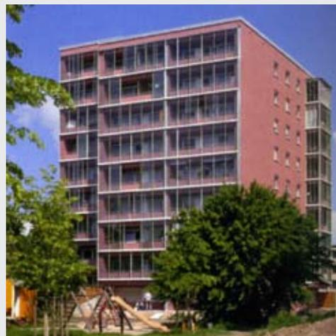
Abbildung 3.3.5 Schaffung eines thermischen Pufferraumes durch Einhausung der Balkone mit Schiebeelementen (Einfachverglasung), Beispiel: Sanierung eines Punkthauses (Baujahr 1968) in Ingolstadt durch Adam Architekten, München (2003); Bildquelle: [Richarz et al. 2006]
