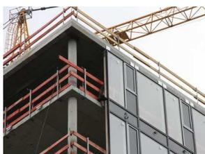
Pfosten-Riegel-Fassaden werden aus tragenden Profilen, die wahlweise mit Fenstern oder mit opaken Elementen ausgefacht werden, aufgebaut. Sie sind konstruktiv nicht für eine nachträgliche Dämmung mit einem Wärmedämmverbundsystem geeignet. Pfosten-Riegel-Fassaden werden energetisch ertüchtigt, indem nur die Gefache ausgetauscht werden. Wenn die tragenden Profile jedoch schlecht gedämmt sind, kann nur die gesamte Konstruktion ausgetauscht werden.
