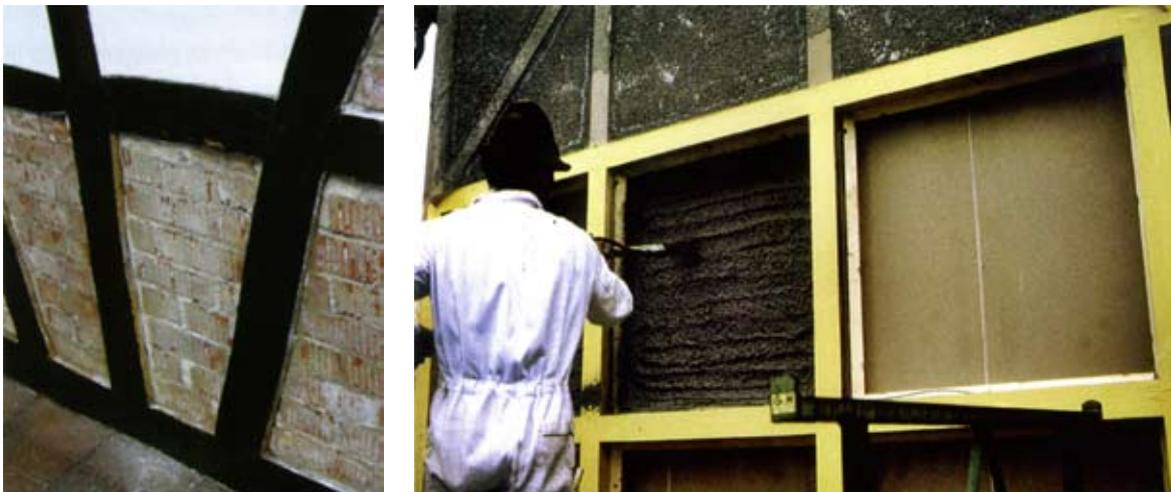
**Abbildung 3.2.5** Ausmauern der Gefache mit Mauersteinen (links) [Eßmann et al. 2005], Verfüllen der Gefache mit Gefachemörtel (rechts) [Künzel 2007]
