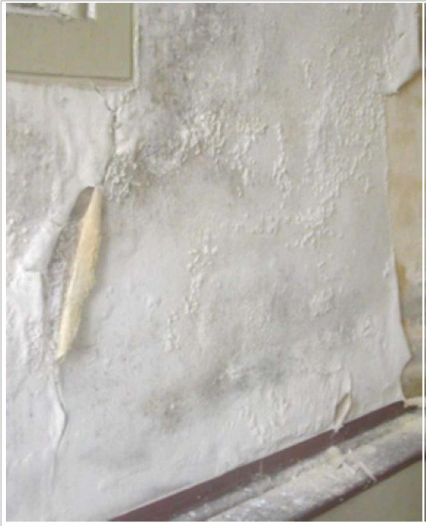
**Feuchte- und Salzschäden an Wänden**
