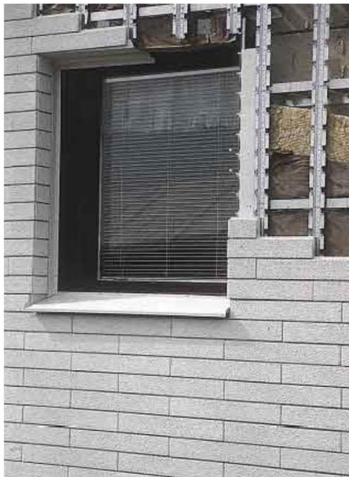
Keramische Fassaden-Elemente werden in ein Schienensystem eingehängt (System Marmoroc)
