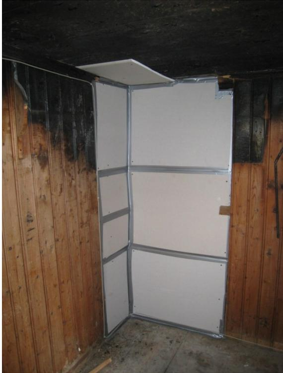
Abbildung 6-17: Ausbesserung Brandschaden in Raum 0.5
