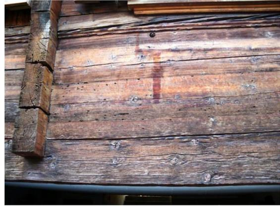
Abbildung 2-2: Blockbau mit besägten Hölzern (einbindende Innenwand zu sehen);
