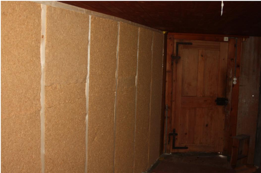
Abbildung 5-4: von außen gedämmte Südwand des Raumes 0.2
