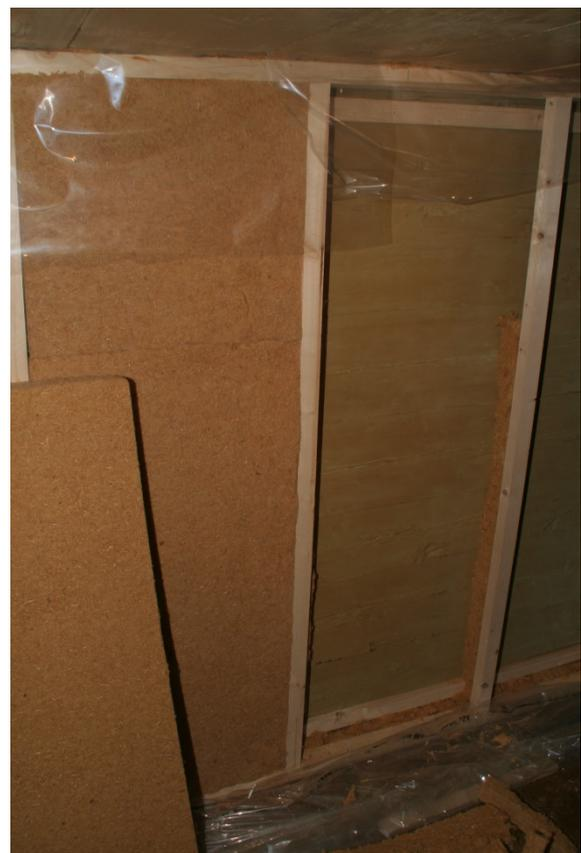
Abbildung 5-1: Skizze Vorsatzschale (links) und Einbau der Vorsatzschale, Holzfaserdämmung und überlappender Dampfbremse (rechts)
