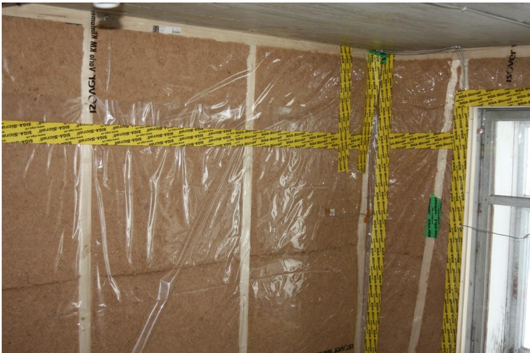
Abbildung 5-3: Endzustand Innendämmung
