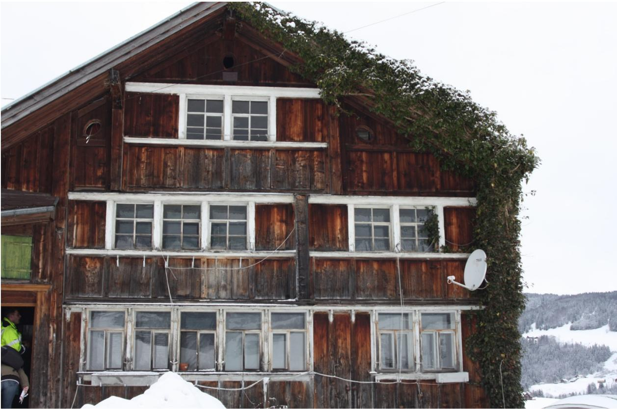
Abbildung 2-6: Hauptfassade (Ost) des untersuchten Objektes mit Appenzeller Täfer
