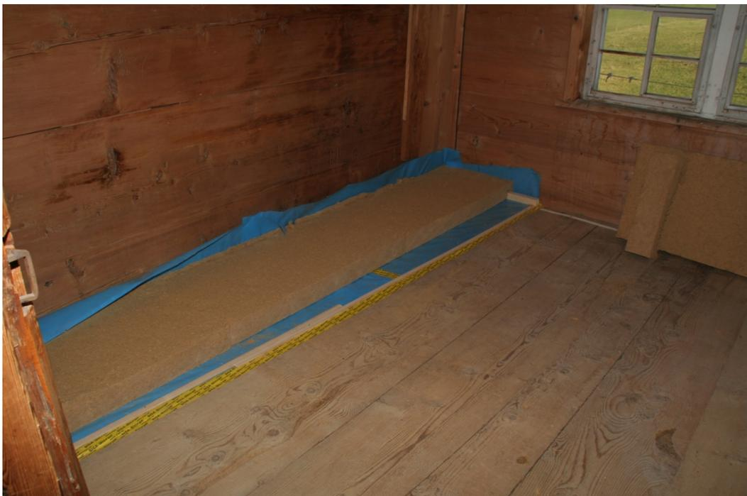
Abbildung 5-5: Dämmkonstruktion Dachgeschoss im Bauzustand
