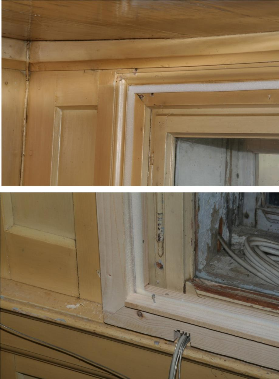
Abbildung 5-8: Details Fensterkonstruktion (oben: Vorbereitung Bestand, unten: Endzustand)
