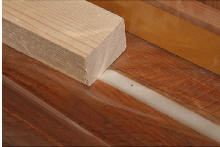
Abbildung 5-2: Kompriband unterhalb Dampfbremse und Rahmenkonstruktion
