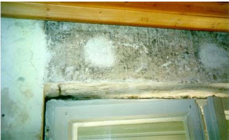
Abbildung 10-3: Schimmelpilzbildung hinter einer punktuell verklebten Gipskartonplatte mit Polystyrolkaschierung, aus: [25]
