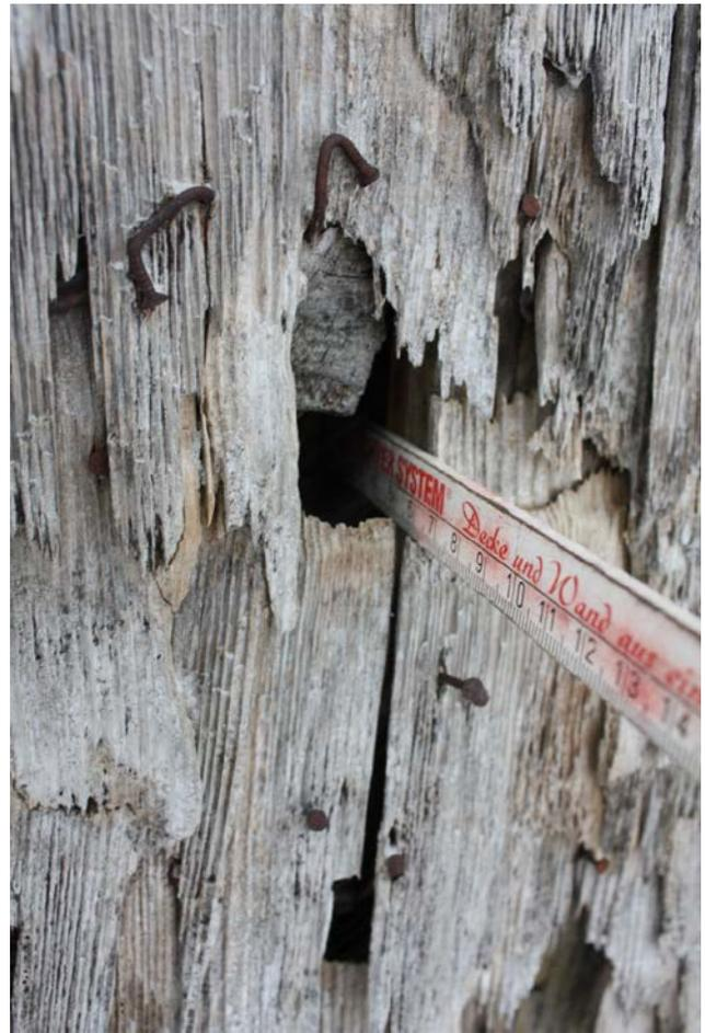
Abbildung 13-10: Abstand Verschindelung zur Strickoberfläche
