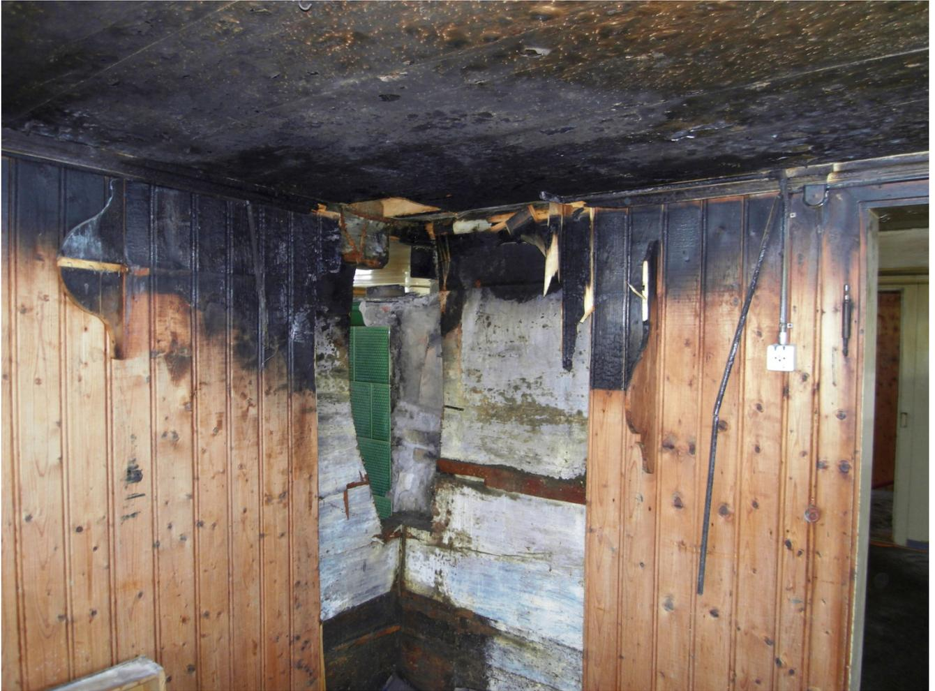
Abbildung 13-12: Querlattung in Wandmitte hinter Holzverkleidung
