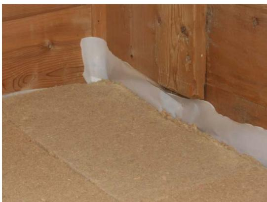
Abbildung 6-21: am Rand ausgefranste Dämmung
