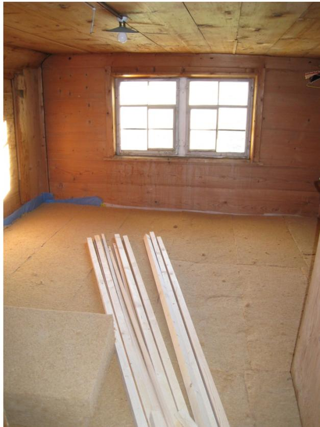
Abbildung 5-6: Endzustand Dämmung Dachboden
